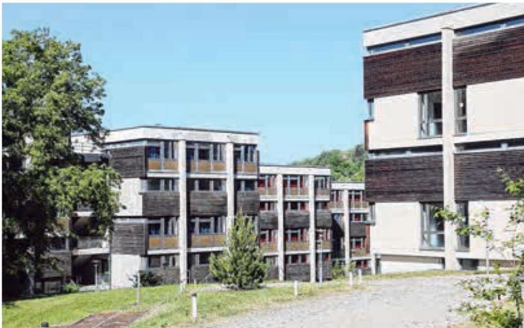
Die Bauarbeiten an einem weiteren Unterkunftsgebäude des Bildungszentrums der Oberfinanzdirektion Karlsruhe am Herliköfer Berg sollen noch dieses Jahr beginnen und 2020 fertig sein. Foto: Tom
