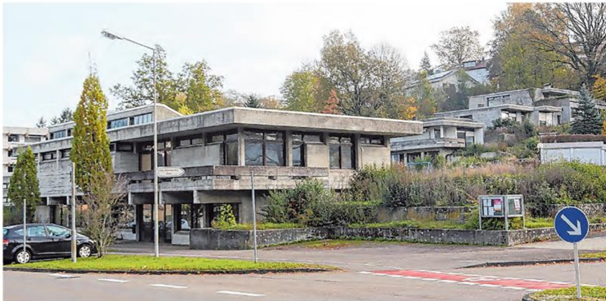
Vorher: Noch stehen die im Jahre 1969 in Betonbauweise erstellten Gebäude – Kindergarten, Gemeindesaal, Mietwohnungen und Pfarrhaus – auf dem ehemaligen „Brücke“-Areal. Im kommenden Frühjahr sollen sie abgerissen werden.
