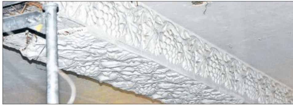
Mehrere dieser wunderschönen Stuck-Träger sind unter einer Zwischendecke versteckt.
