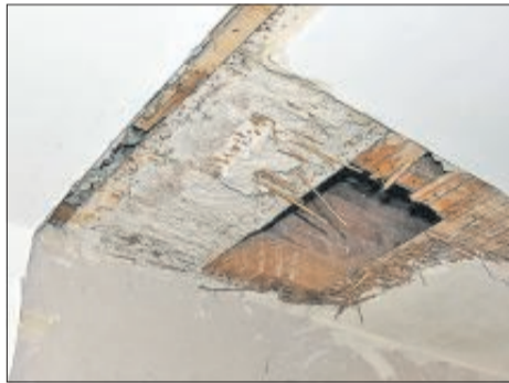
Blick in die bisher verborgene Bausubstanz.
