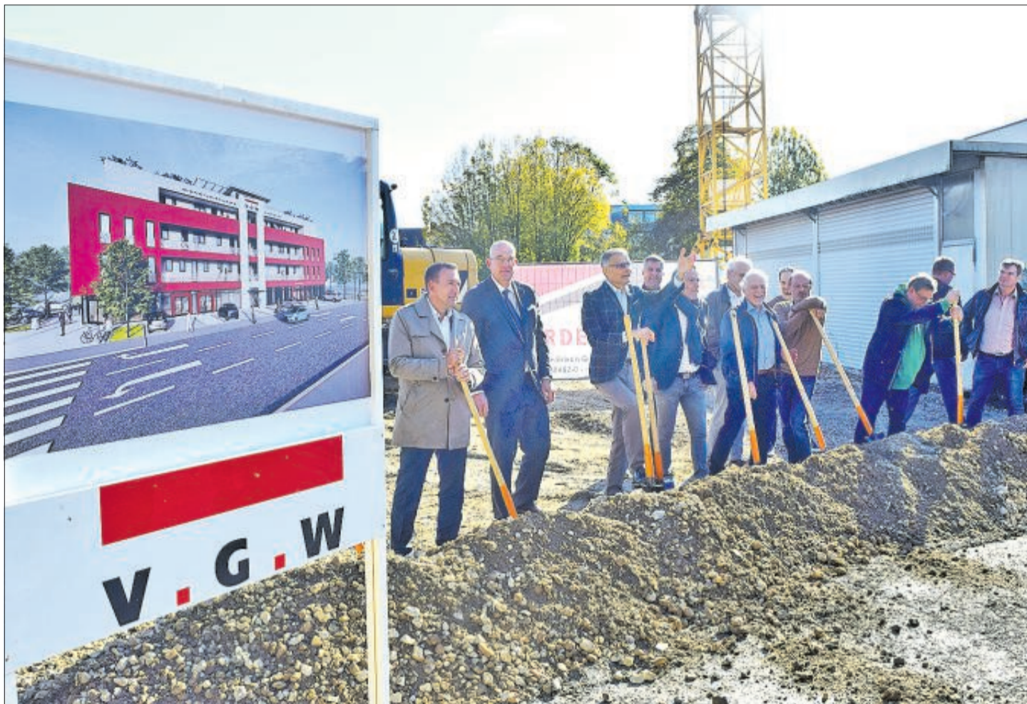
Spatenstich für ein Bauprojekt, das die urbane Infrastruktur des Stadtteils deutlich aufwertet.
