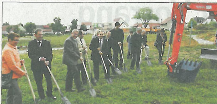
Spatenstich im Finkenweg in Neuler: Die Kreisbau investiert rund 1,7 Millionen Euro für seniorengelechtes Wohnen. (Foto: Königier)
